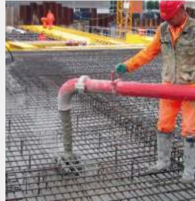
Un mayor tiempo de manejabilidad facilita el transporte, descargue y vibración del concreto. Conservar la fluidez del concreto en el tiempo es crucial en operaciones de bombeo (evita bloqueos), como de colocación con balde donde el remezclado es limitado.
