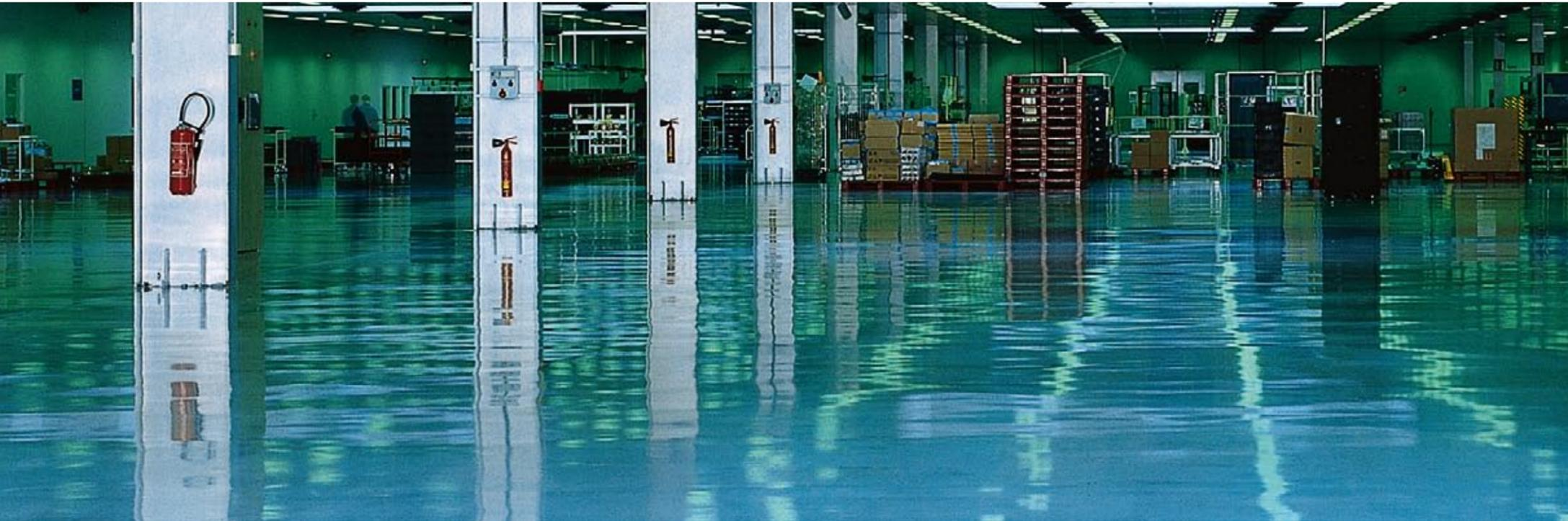
Con los sistemas Sikafloor®-261 se requiere únicamente de un ligante epóxico más un imprimante, un espesante y arena de cuarzo especialmente gradada y tratada para cubrir hasta el 70% de todas las necesidades:
