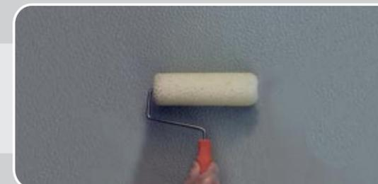
Sello de un piso autonivelante utilizando rodillo de pelo corto
