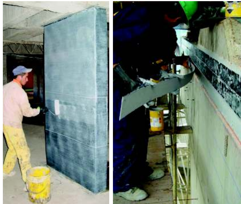
Conformación de refuerzo externo CFRP con impregnación de tela de fibra de carbono y/o pega al concreto con adhesivo epóxico.
