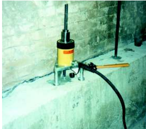
Ensayo de campo de anclaje químico de barra al concreto
