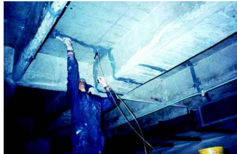
Inyección de fisuras con resina epóxica en losa de concreto reforzado.
