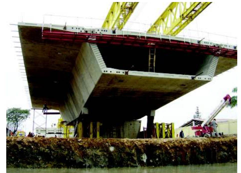
Construcción de puente segmentado con dovelas prefabricadas, con tendones internos, pega y sello de segmentos con adhesivo epóxico.
