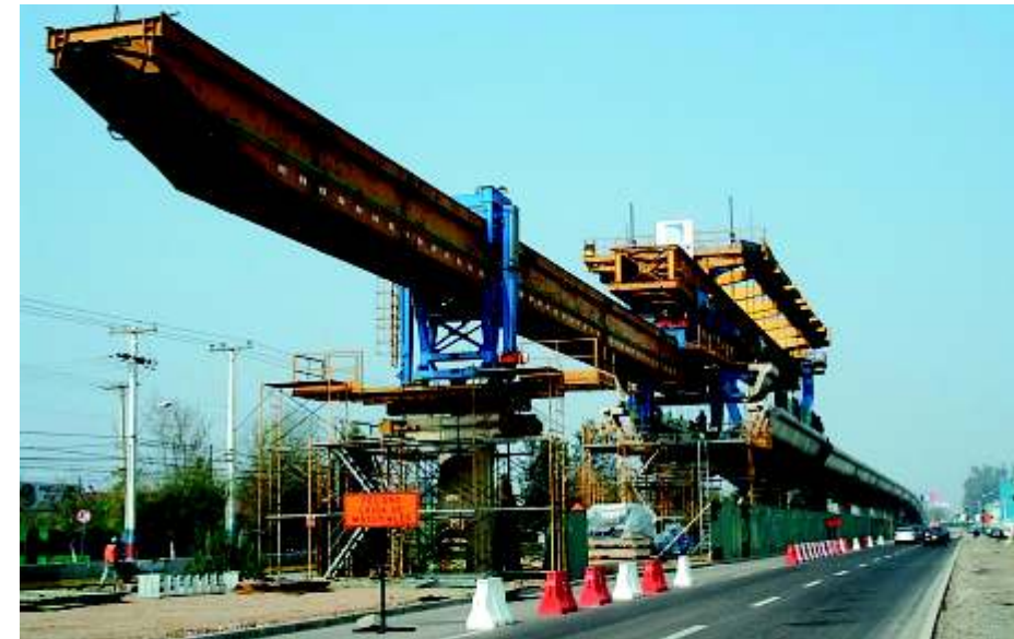
Construcción de puente segmentado con dovelas prefabricadas, con tendones internos, pega y sello de segmentos con adhesivo epóxico.
