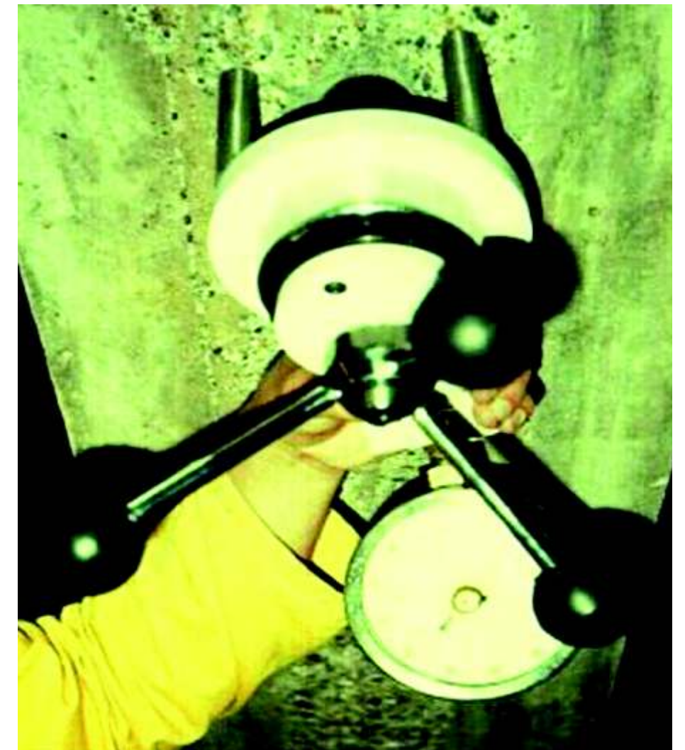
Ensayo de adherencia a tensión directa en sitio para verificación de calidad del sustrato previo al reforzamiento en viga.
