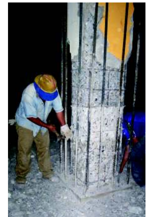
Remoción de concreto con maceta y cincel en columna a reforzar. Posterior preparación se superficie es requerida para remover concreto microfisurado.
