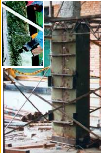
Superficie de concreto preparada en encamisado metálico con relleno de concreto de baja retracción y uso de puente de adherencia epóxico.
