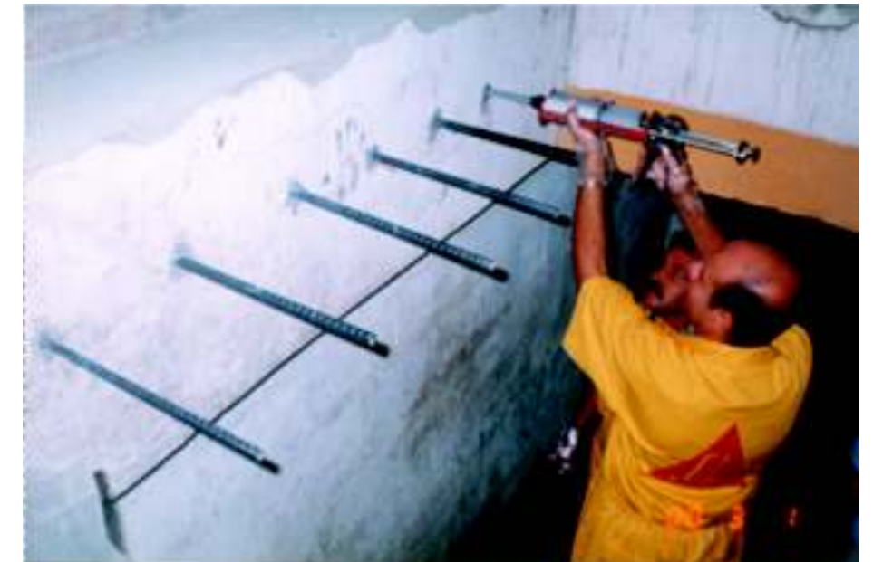
Anclaje químico de barras con adhesivo epóxico en losa de concreto.
