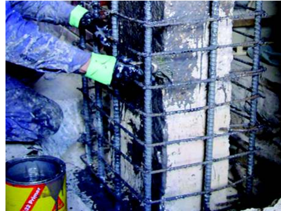
Aplicación de puente de adherencia epóxico entre concreto nuevo y viejo en reforzamiento de columna con concreto
