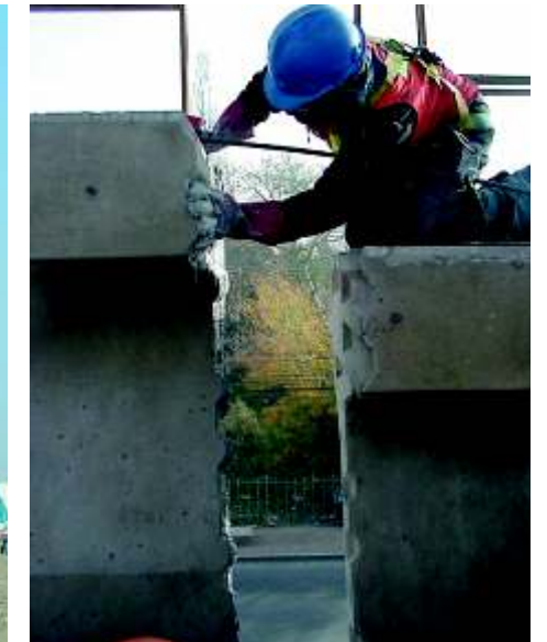
Construcción de puente segmentado con dovelas prefabricadas, con tendones internos, pega y sello de segmentos con adhesivo epóxico.
