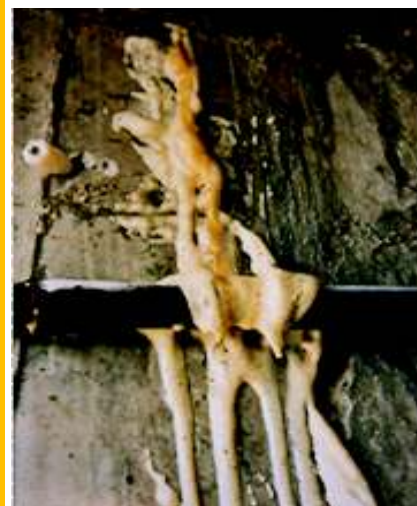
Inyección de fisuras con resina de poliuretano en tanque de agua.
