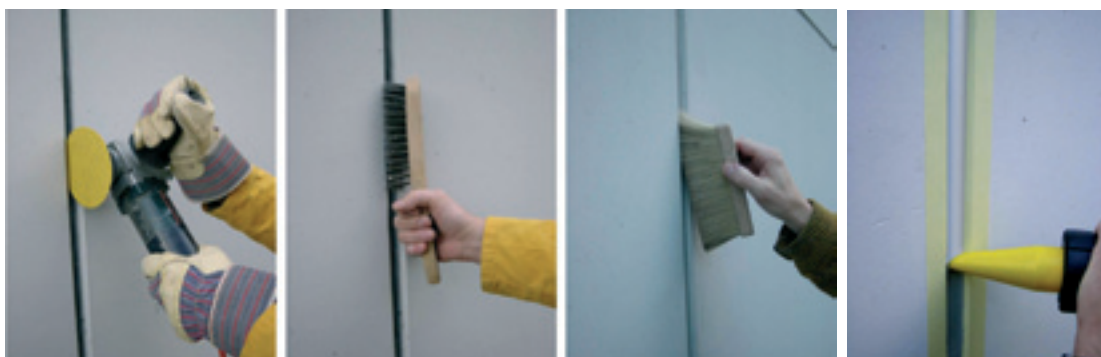
Foto No.3: Procedimiento para el sello de una junta
