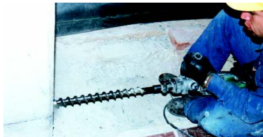
Perforación para colocación de pernos roscados
