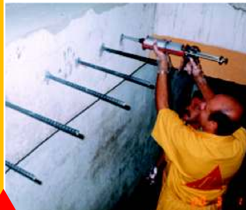
Anclaje químico de barras para conectar nueva losa de concreto
