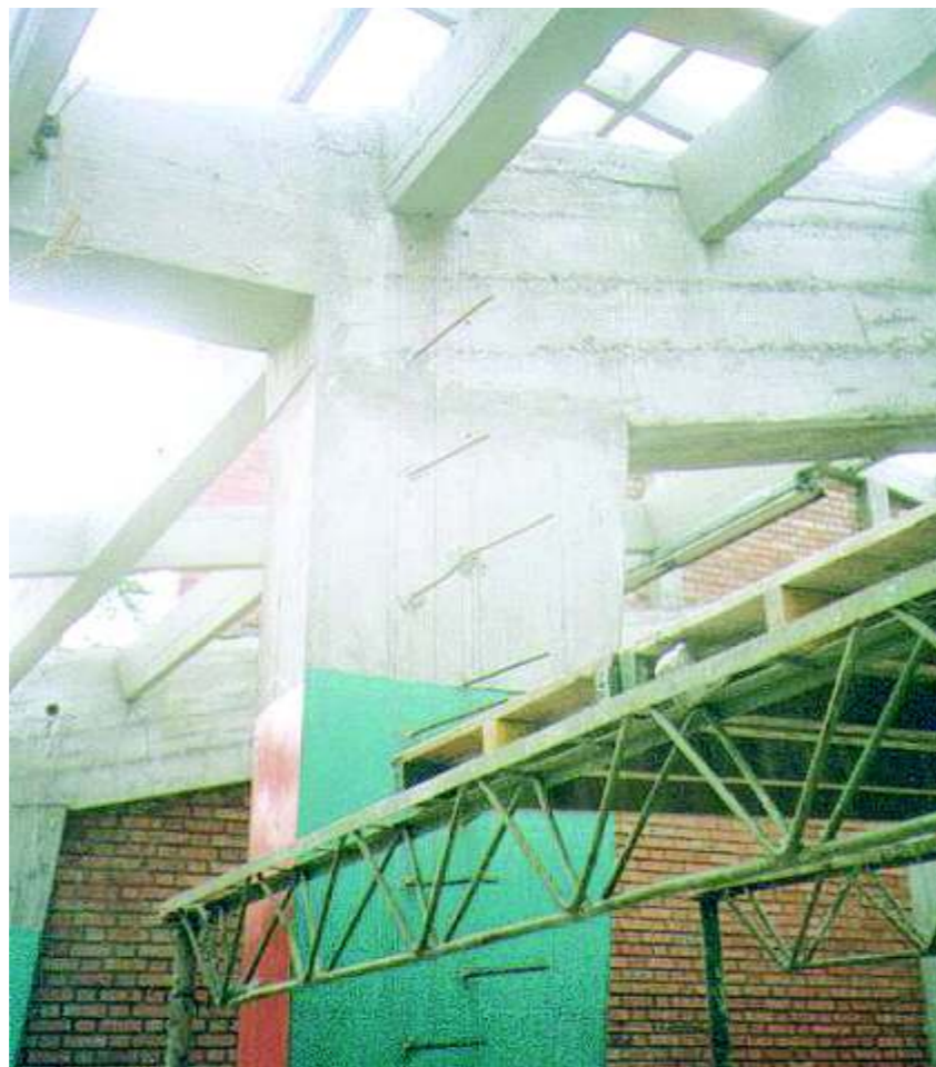
Anclaje de varillas para conectar nuevos muros de concreto
