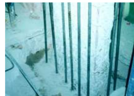
Anclaje de varillas para conectar el nuevo recrecimiento o encaquetado de concreto en columnas.
