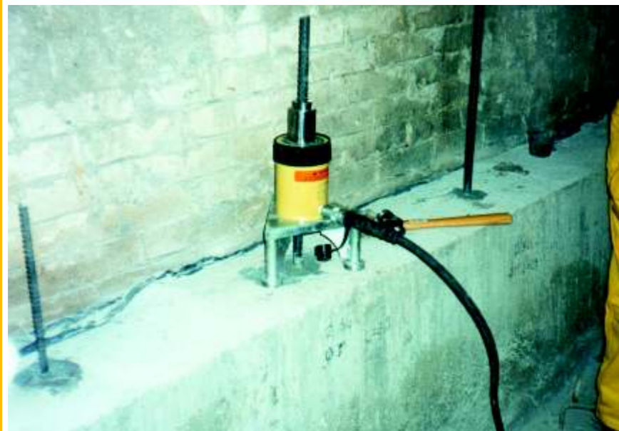
Ensayo de campo de anclaje de varilla al concreto
