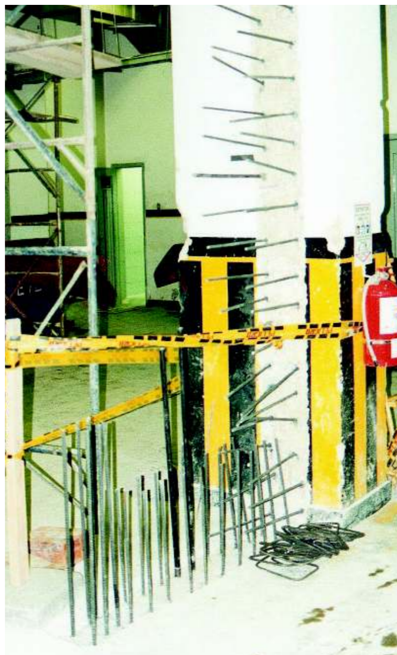
Anclaje de varillas para conectar nuevos muros de concreto
