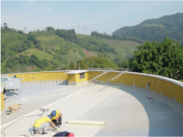
Cubierta Edificio de Mando Central Hidroeléctrica San Carlos
