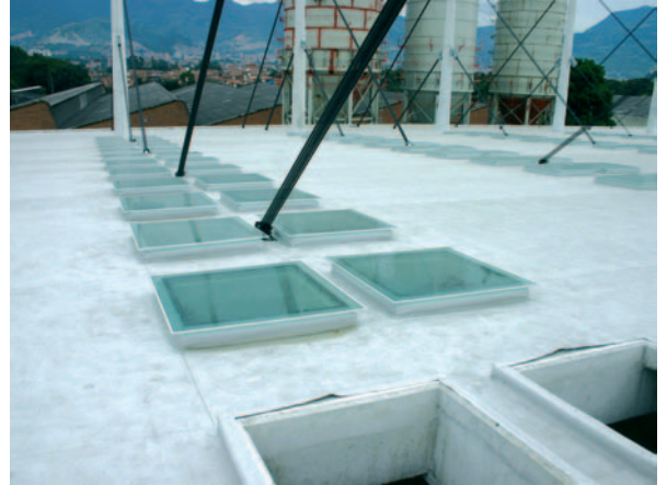
Cubierta en estructura colgante sobre prefabricados.
