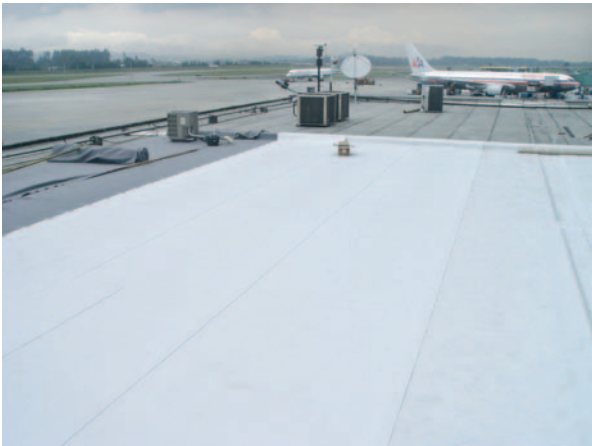
Cubierta Aeropuerto El Dorado, Bogotá
