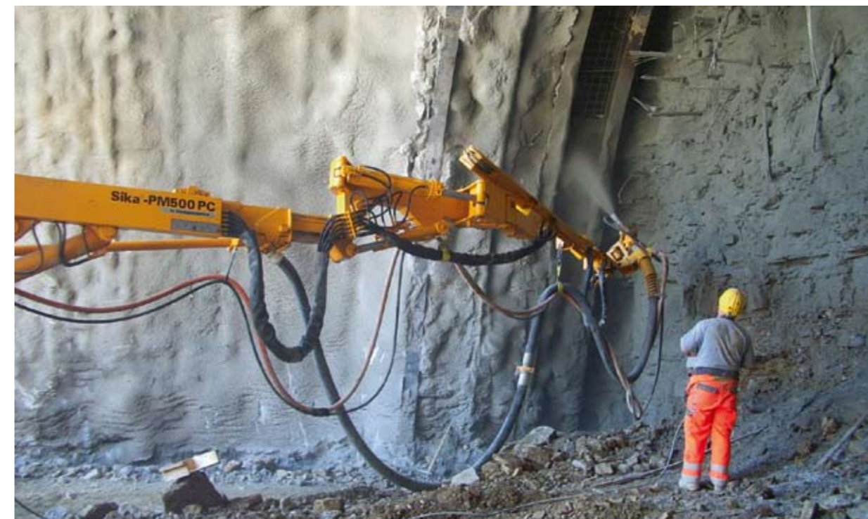
Túnel Neckarwestheim - Sika PM500, Alemania.
