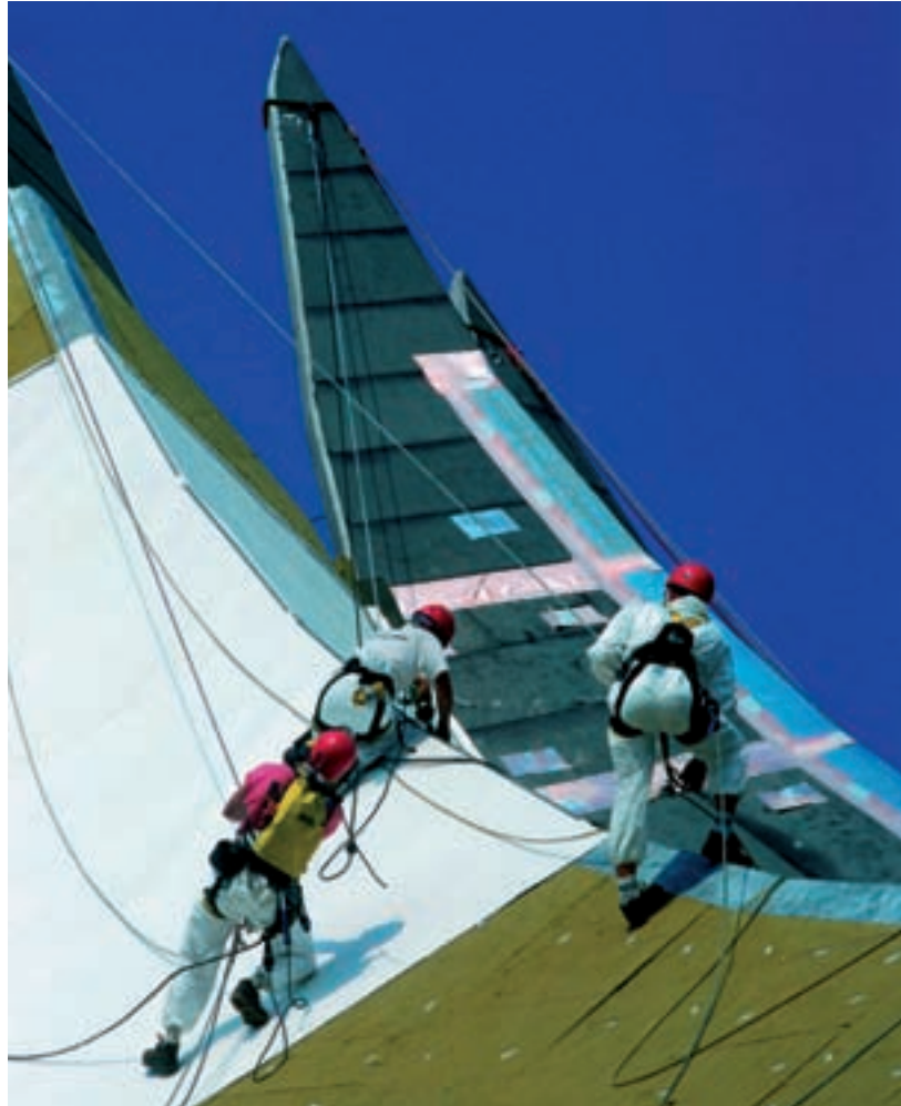
Aplicación de la membrana de una sola capa en Tempodrom, Alemania
