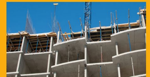
FUNDICIÓN IN-SITU Y PREFABRICADOS DE CONCRETO
