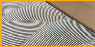
INSTALACIÓN DE PISOS
