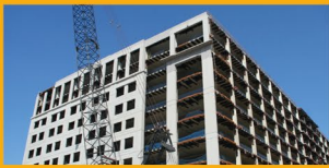
REPARACIÓN DE CONCRETO
