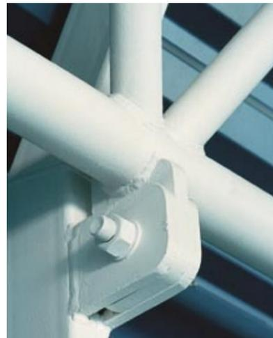
Tuberías cilíndricas o de secciones cuadradas se escogen más frecuentemente por su apariencia visual. Los recubrimientos intumescentes con **Sika® Unitherm®** dan protección contra el fuego sin afectar la apariencia de la estructura. El rango de terminados decorativos de **Sika® Unitherm®** también realzará la apariencia de la estructura.
