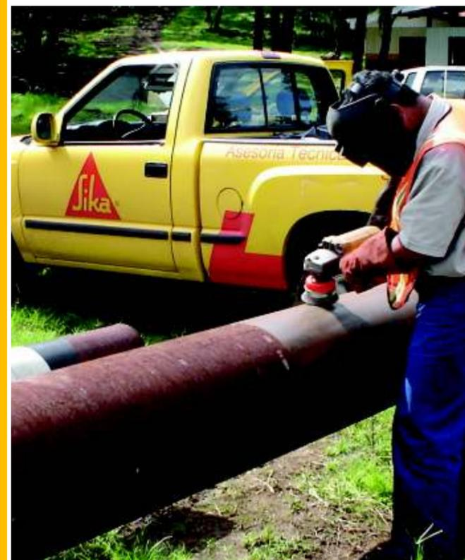
La limpieza con herramientas eléctricas o neumáticas, es un método para remover la cascarilla de laminación desprendida, herrumbre suelta y pintura descascarada con cepillos eléctricos o neumáticos, impacto eléctrico o neumático, esmeril eléctrico o neumático ó por la combinación de estos métodos.
