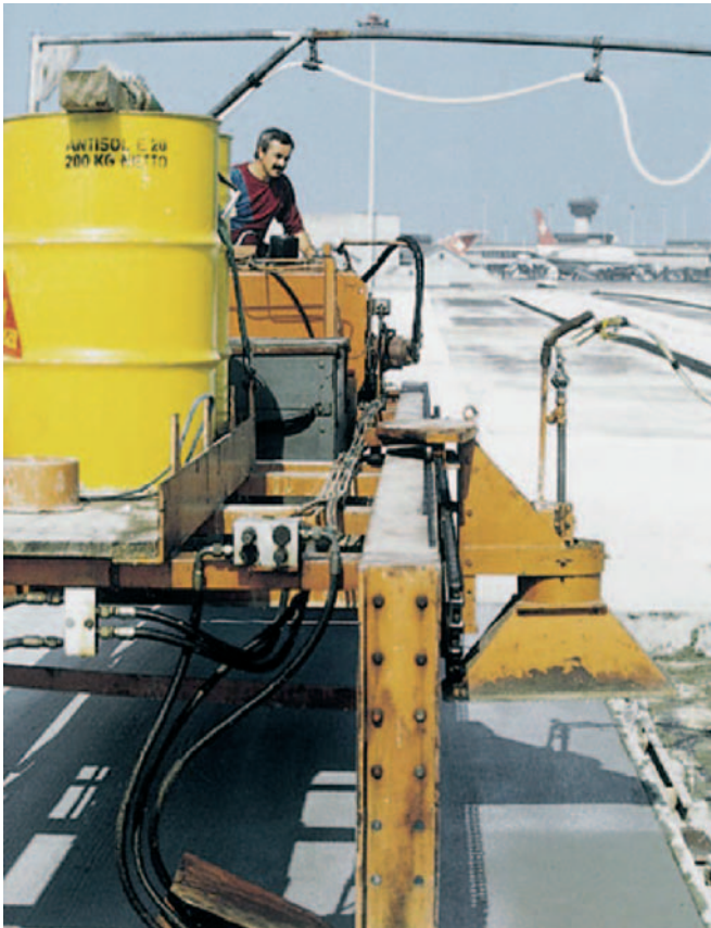
Foto No.6: Automatización del curado de un pavimento de concreto para un aeropuerto.
