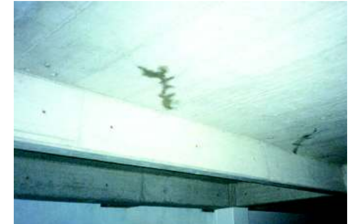
Fisuras de retracción del concreto con presencia de humedad en losa de parqueadero por falta de juntas
