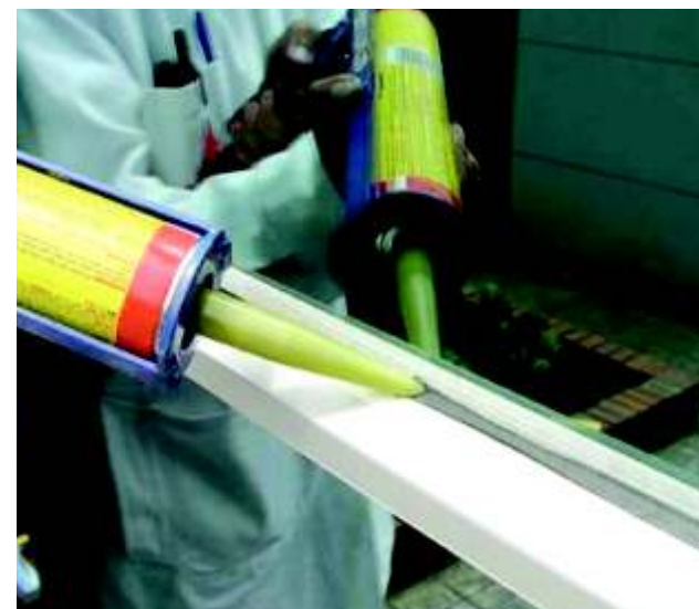
Sellado de junta entre vidrio y marco de ventana
