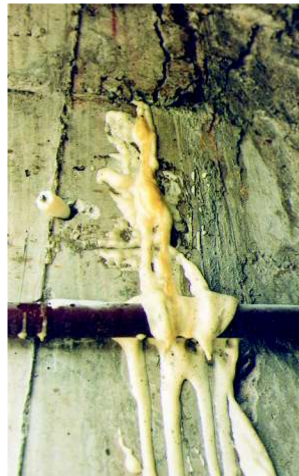
Inyección elástica con resina de poliuretano de fisura en tanque
