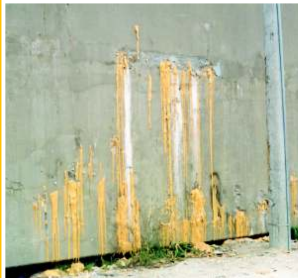
Inyección elástica con resina de poliuretano de fisuras en muro de concreto en tanque
