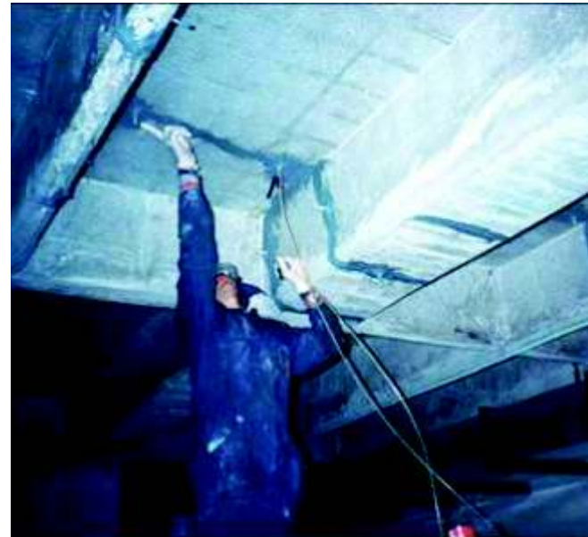
Inyección de fisura con resina epóxica en losa de concreto
