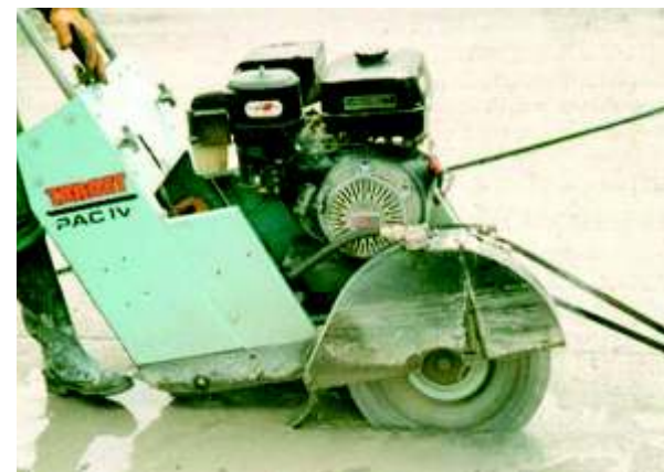
Corte de junta de control o inducida en pavimento
