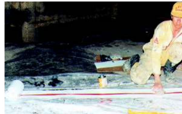
Reparación de juntas con membrana elástica adherida con epóxico al soporte
