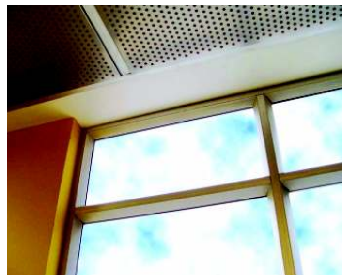
Sellado de junta entre vidrio y marco, entre marco y muro en ventana
