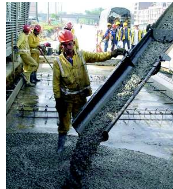
Detalle de los pasadores metálicos en junta de pavimento y vaciado del concreto
