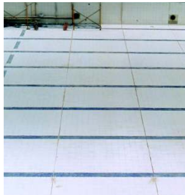
Reparación con colocación de juntas de dilatación en mortero de pega y nivelación en piscina.
