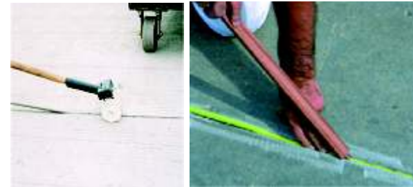
Colocación mecánica de fondo de junta
