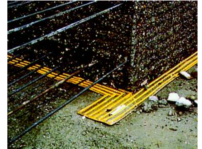
Sello elástico de PVC externo en losa sobre terreno
