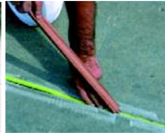
Colocación manual de fondo de junta
