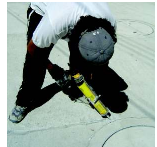
Colocación manual de sellante elástico con pistola en losa de pavimento
