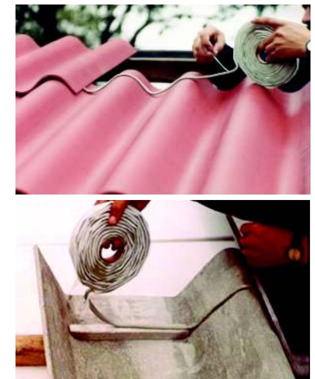
Colocación de sello en juntas de traslape en láminas o tejas corrugadas
