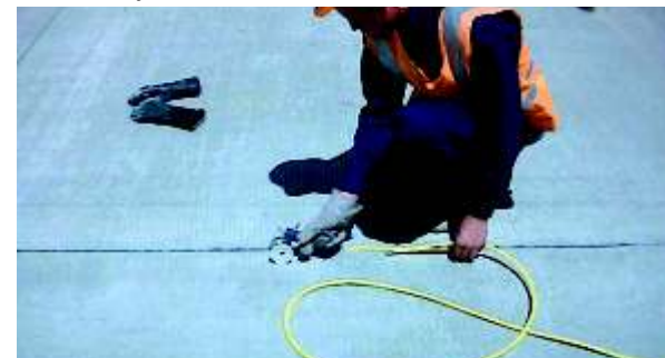
Colocación mecánica de fondo de junta
