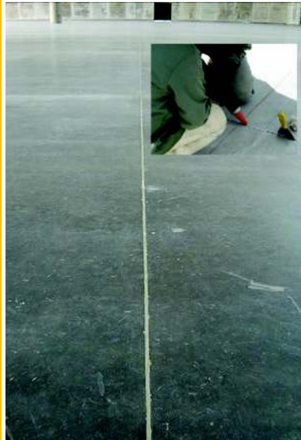
Aplicación de epóxico semi rígido en juntas de piso industrial
