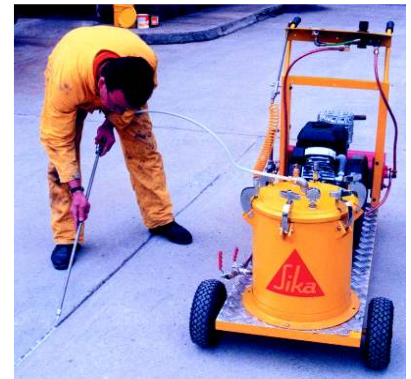
Colocación mecánica de sellante elástico con equipo en losa de pavimento
