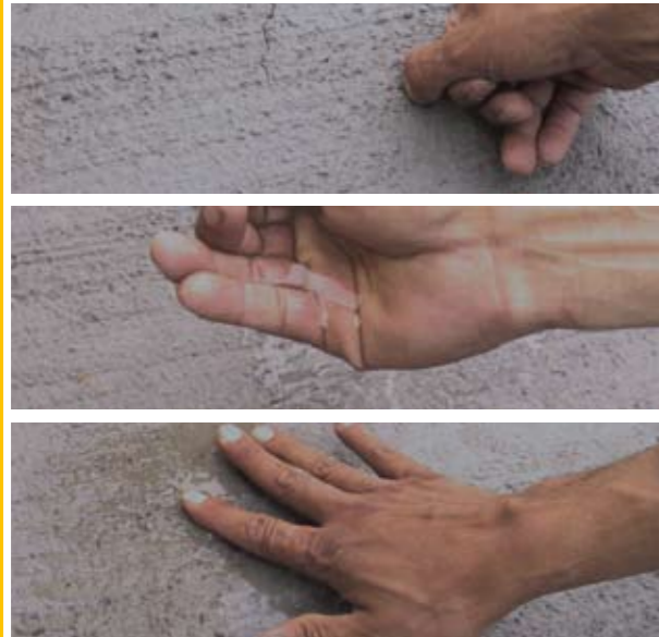
Foto No. 9: Sello de grietas por retracción plástica antes de que el concreto fragüe.
