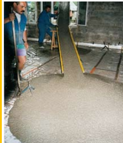
Foto No. 6: Varios ejemplos de la utilización en la construcción del Concreto Autocompactante.
