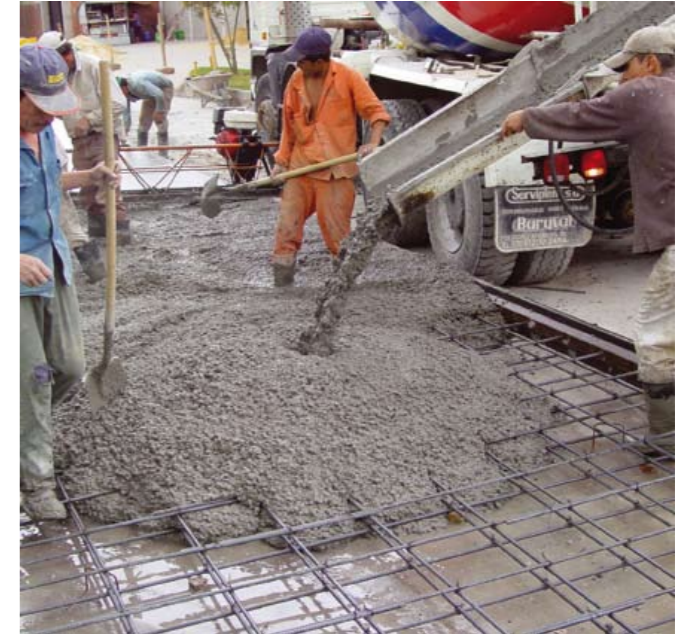
Foto No. 5: Empleo del concreto de alta resistencia inicial (Fast Track) para elaboración y rápida puesta en servicio de una vía.
