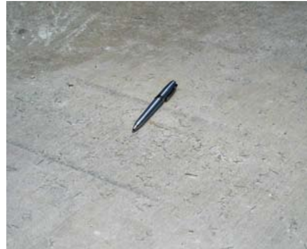
Foto No. 10: Concreto adicionado con fibras para la construcción de andenes y vías.
